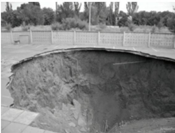
Рис. 1. Провал в центрі міста біля речового ринку (а) діаметром близько 15 м і завглибшки до 10 м та на його околиці (б).
