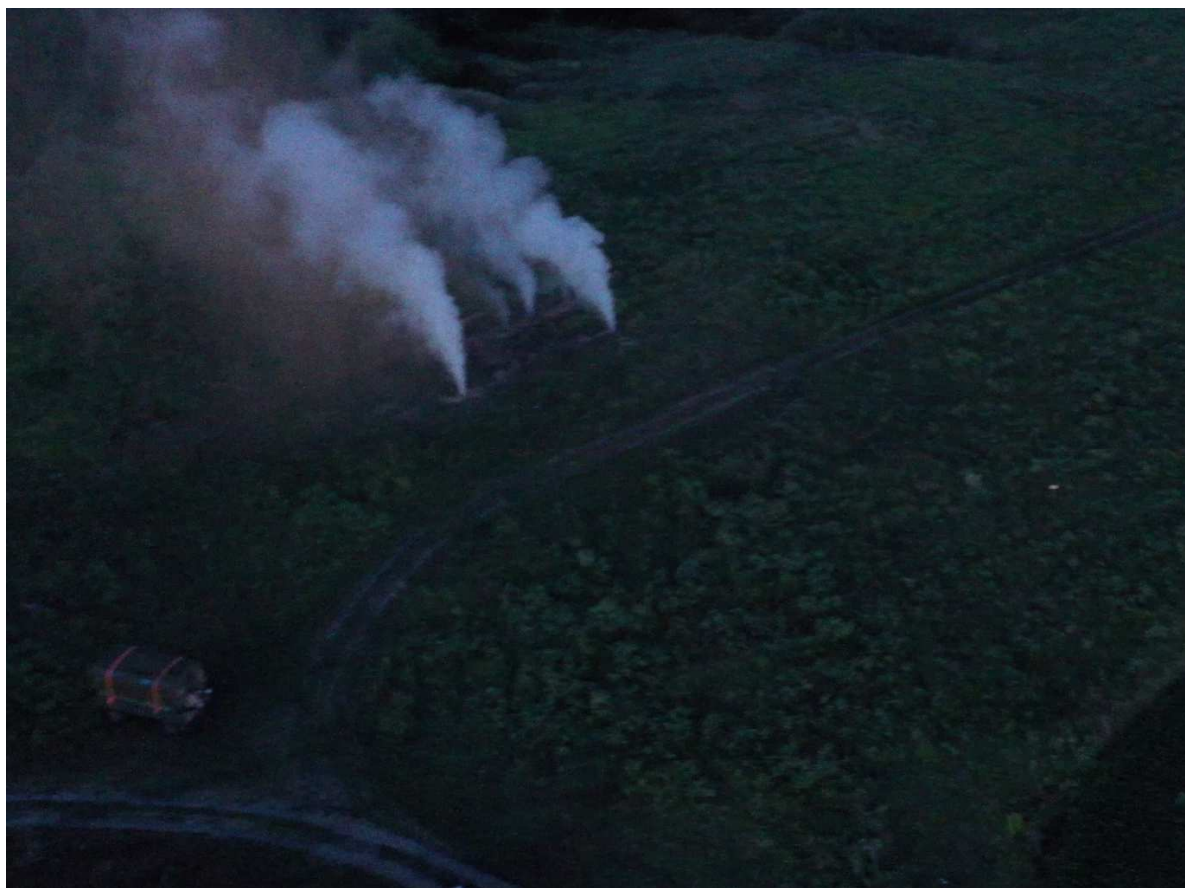
Рис.3. Картина вибуху ПВ 05 з повітря. Вибухівка закладена в свердловини глибиною 30 м кожна.
